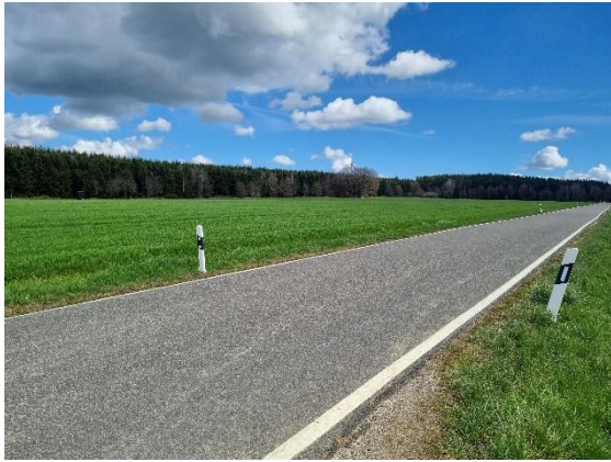
Foto 16: Blick von SW nach NO auf die angrenzende Straße K 106 und den Acker
