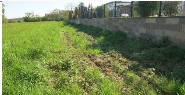
Foto 4: Grasweg entlang der Baugrundstücke am südl. Rand
