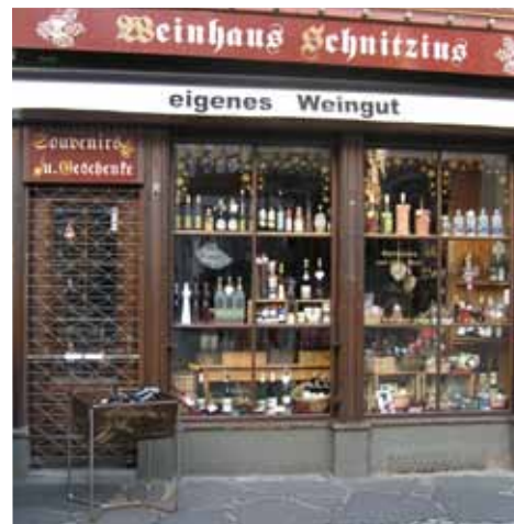
Bernkastel-Kues, Markt - erhaltenswerte Schaufensterkonstruktion aus Holz
