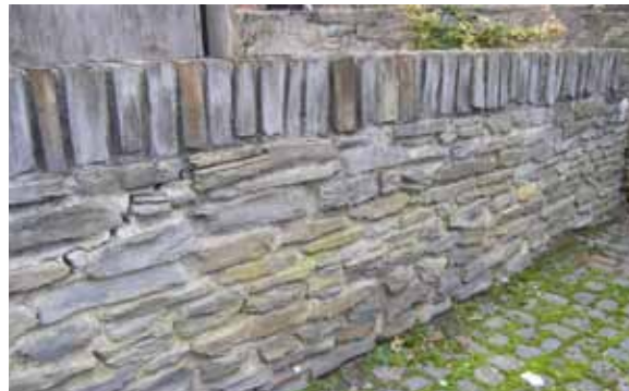
Bernkastel-Kues - Mauer mit Rollschicht
