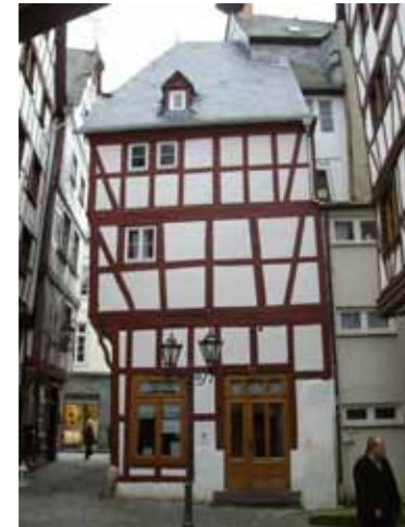
Bernkastel-Kues, Markt - Nach der Sanierung
