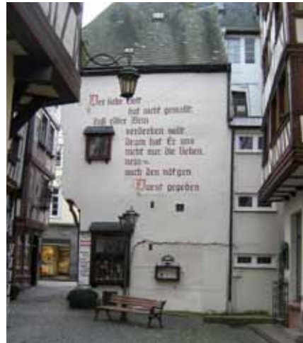
Bernkastel-Kues, Markt - Vor der Sanierung
