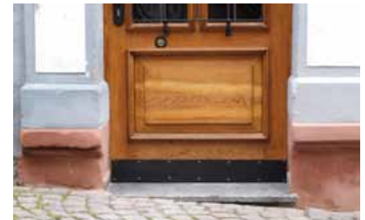
Bernkastel-Kues, Graacherstraße - Typischer Gebäudesockel aus Sandstein
