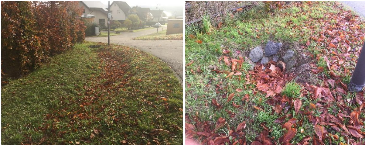
Abbildung 33: Entwässerungsgraben mit Einlauf in der Straße „Auf den Gärten“
