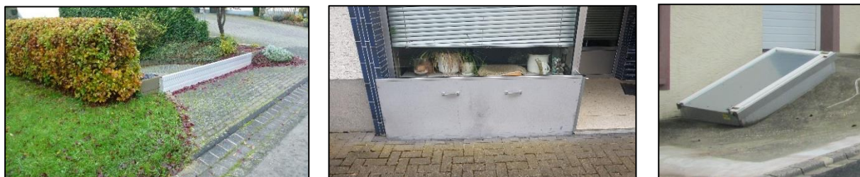
Abbildung 43: Beispiele von Objektschutzmaßnahmen (mobile Steckelemente, Dammbalkensysteme, Abdichtungen)
