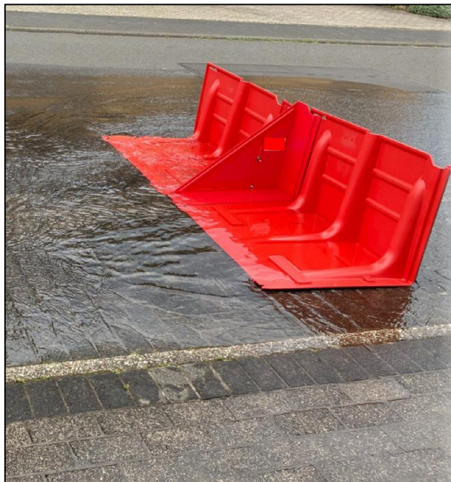
Abbildung 32: Mobile Hochwasserelemente zum Ableiten des Oberflächenwassers
