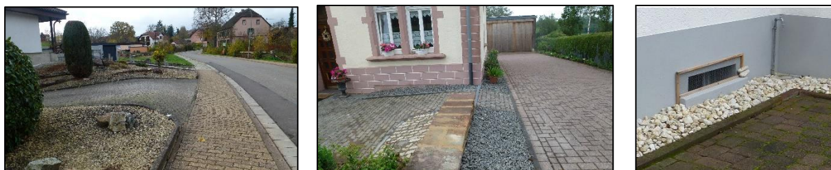
Abbildung 44: Beispiele von Objektschutzmaßnahmen (Überbogen, Geländemodellierungen, Aufkantung am Kellerfenster)
