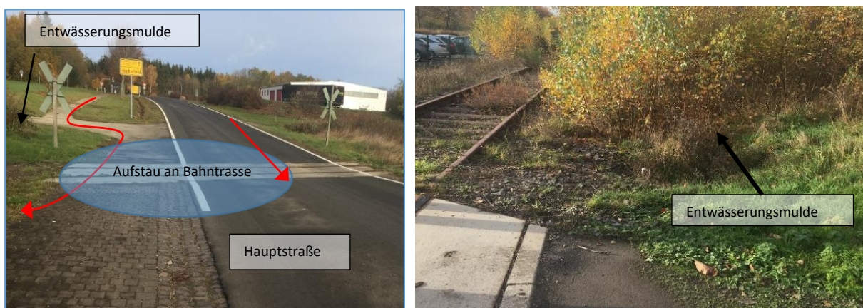
Abbildung 14: Brachgefallene Bahntrasse und Entwässerungsmulde an der Hauptstraße
