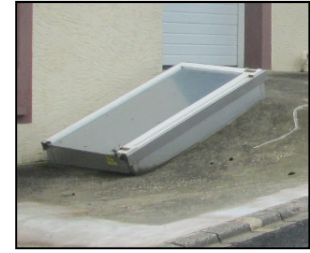
Abbildung 41: Beispiele von Objektschutzmaßnahmen (mobile Steckelemente, Dammbalkensysteme, Abdichtungen)
