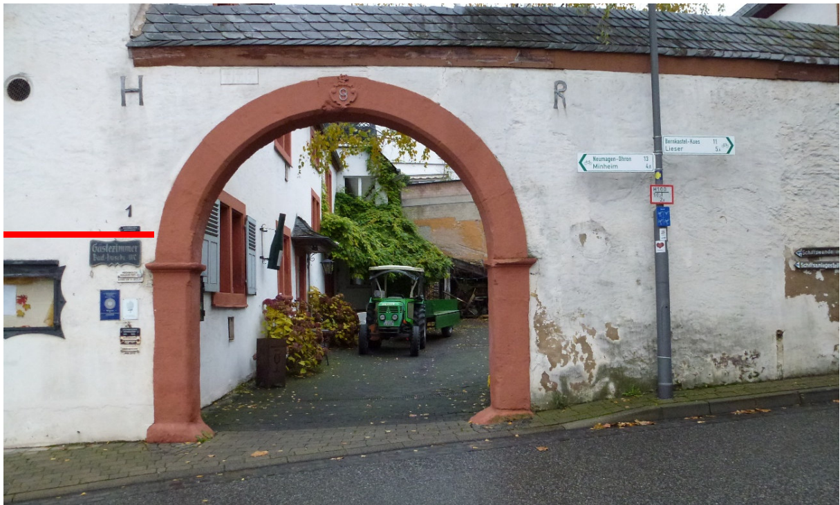
Abbildung 10: Hochwassermarke (rot) des 50-jährlichen Hochwasserereignisses im Jahr 1993
