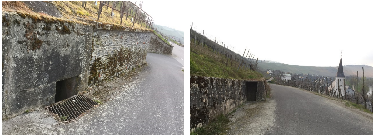
Abbildung 24: Einläufe in den Weinbergen oberhalb von Kesten
