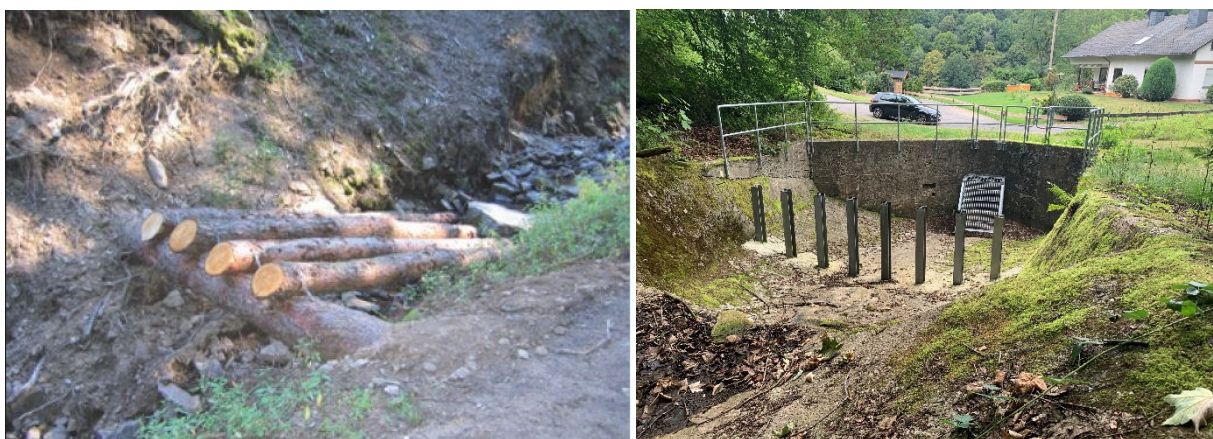
Abbildung 17: Beispiele von Totholz- und Treibgutrechen
