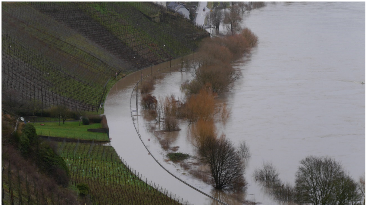
Abbildung 11: Überflutung der K53 im Bereich der Dreismühle in Kesten am 02.01.2018
