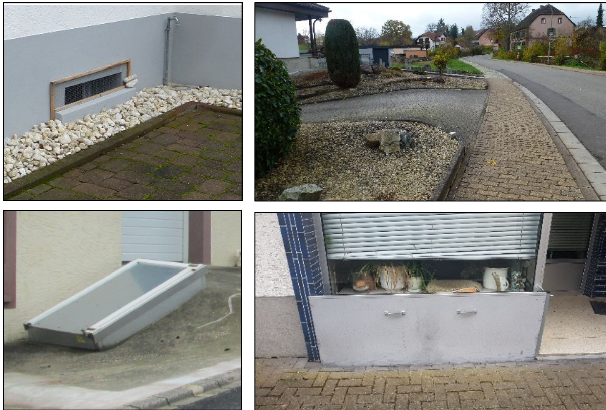
Abbildung 13: Beispiele von Objektschutzmaßnahmen (mobile Steckelemente, Überbogen, Aufkantung am Kellerfenster)
