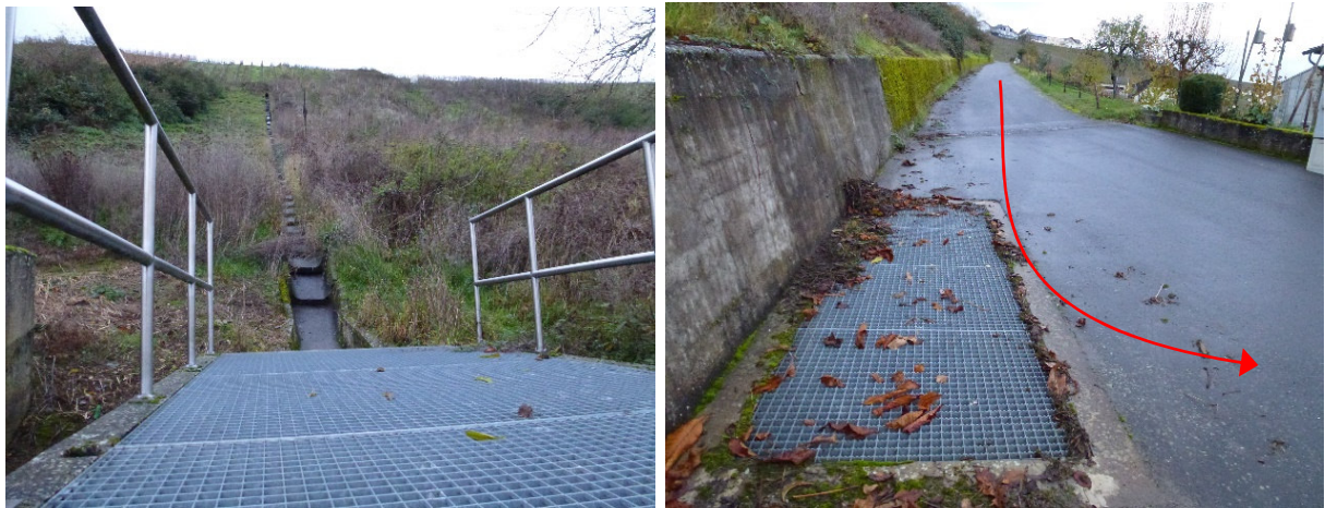
Abbildung 33: Einlaufbauwerk der Weinbergsentwässerung und Straßeneinlauf in Wirtschaftsweg
