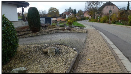
Abbildung 42: Beispiele von Objektschutzmaßnahmen (Überbogen, Geländemodellierungen, Aufkantung am Kellerfenster)
