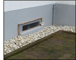
Abbildung 42: Beispiele von Objektschutzmaßnahmen (Überbogen, Geländemodellierungen, Aufkantung am Kellerfenster)
