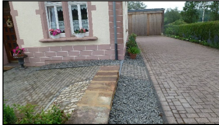
Abbildung 42: Beispiele von Objektschutzmaßnahmen (Überbogen, Geländemodellierungen, Aufkantung am Kellerfenster)
