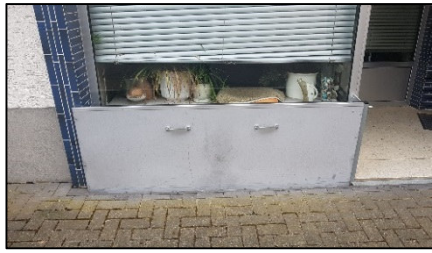
Abbildung 41: Beispiele von Objektschutzmaßnahmen (mobile Steckelemente, Dammbalkensysteme, Abdichtungen)
