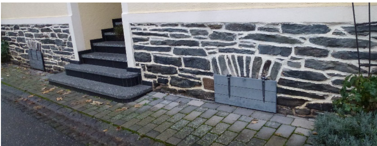
Abbildung 43: Objektschutzmaßnahme in Kesten
